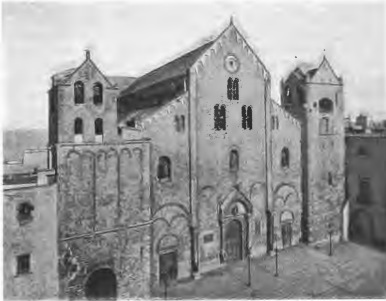
Базилика св. Николая съ западной стороны.
